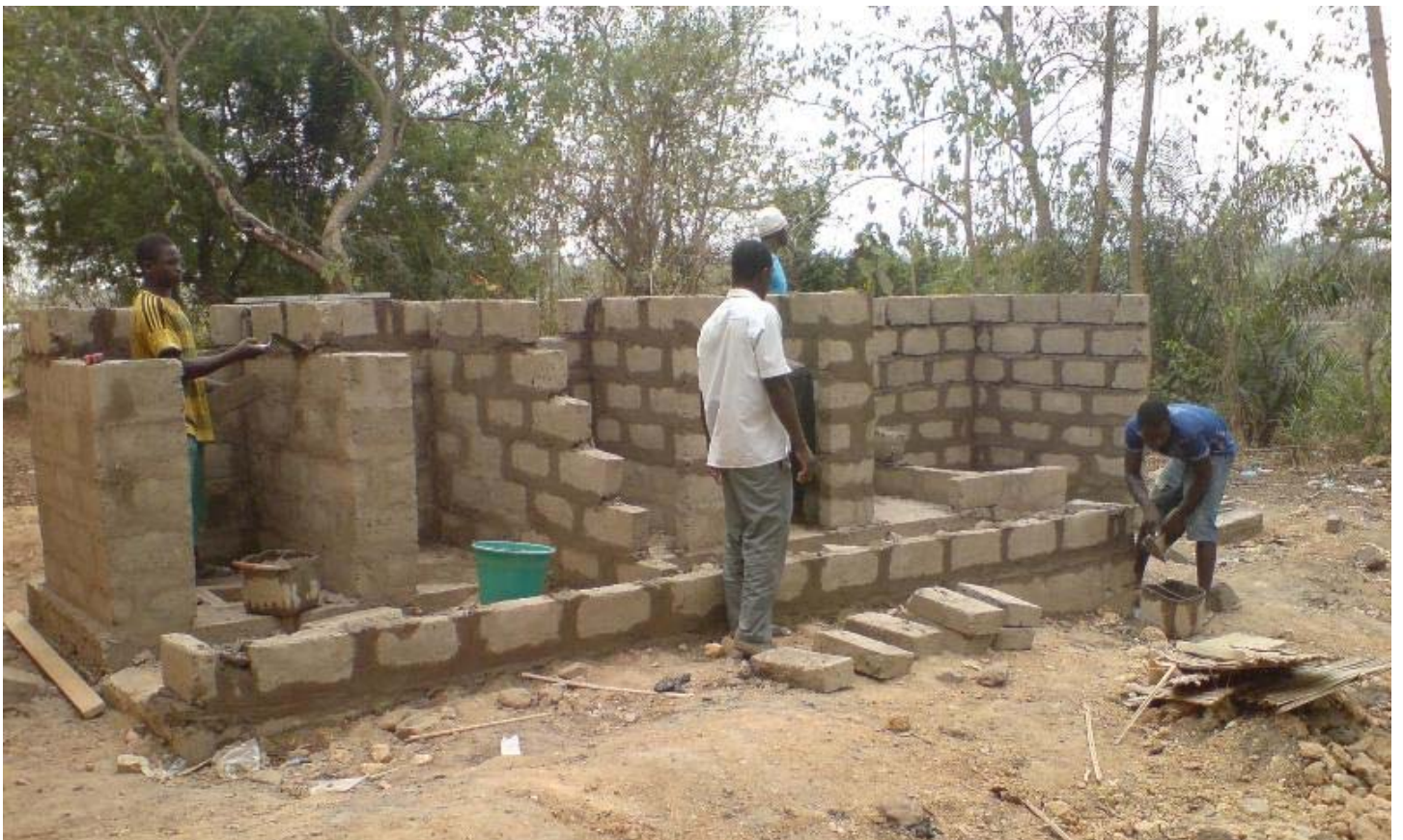
März 2016: Der Bau nimmt Formen an
