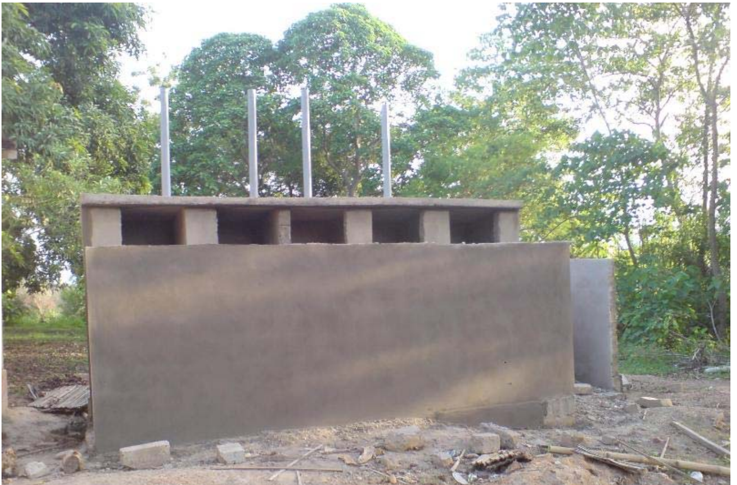
April 2016: Jetzt wird verputzt. Und bald wird eingeweiht.
