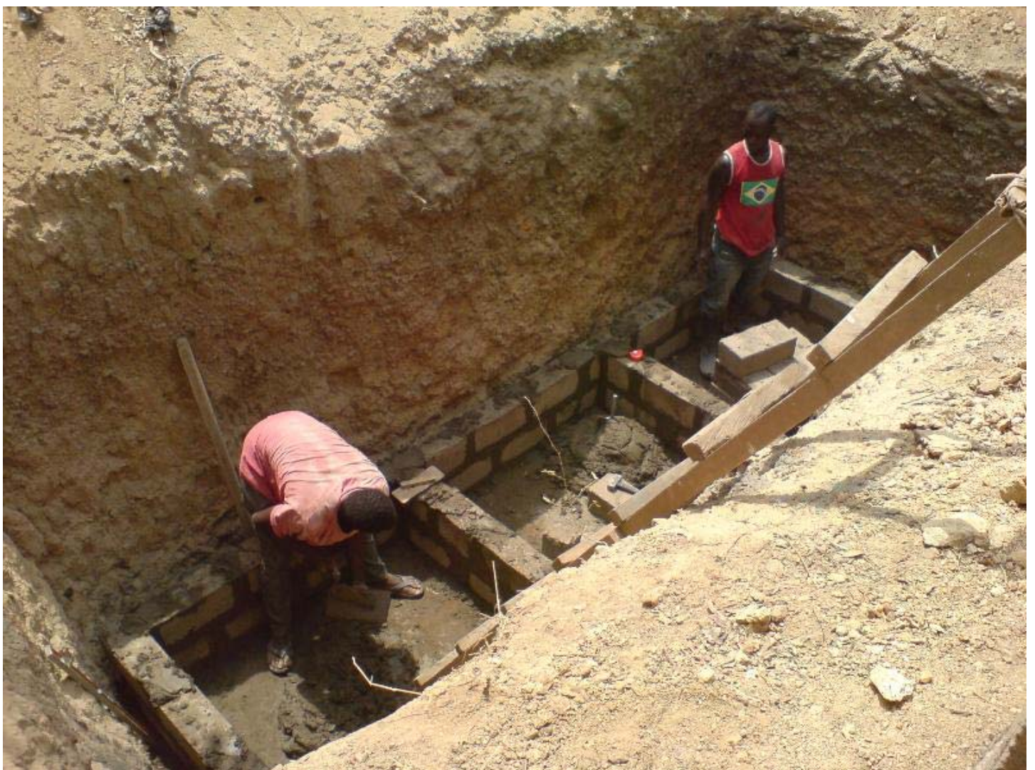
Aushebung für Bau und Fundamente. Eigenleistung der Realschule.
