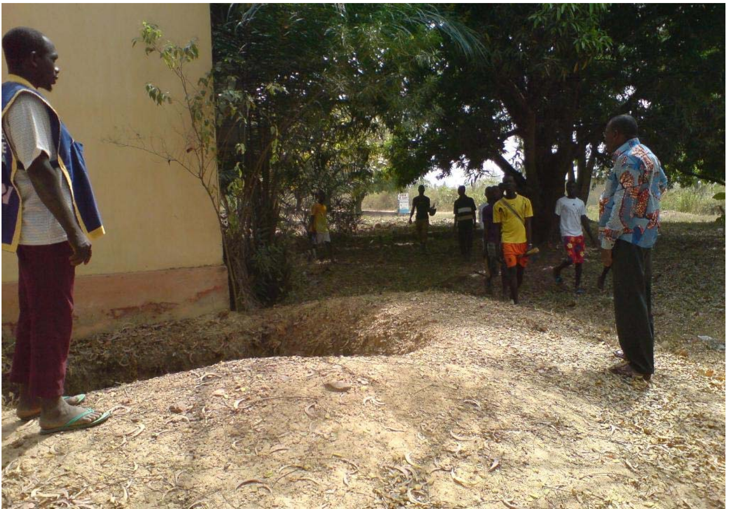
Januar 2016: Der Toiletten-Bauplatz. An der alten ersten Aushebung.
