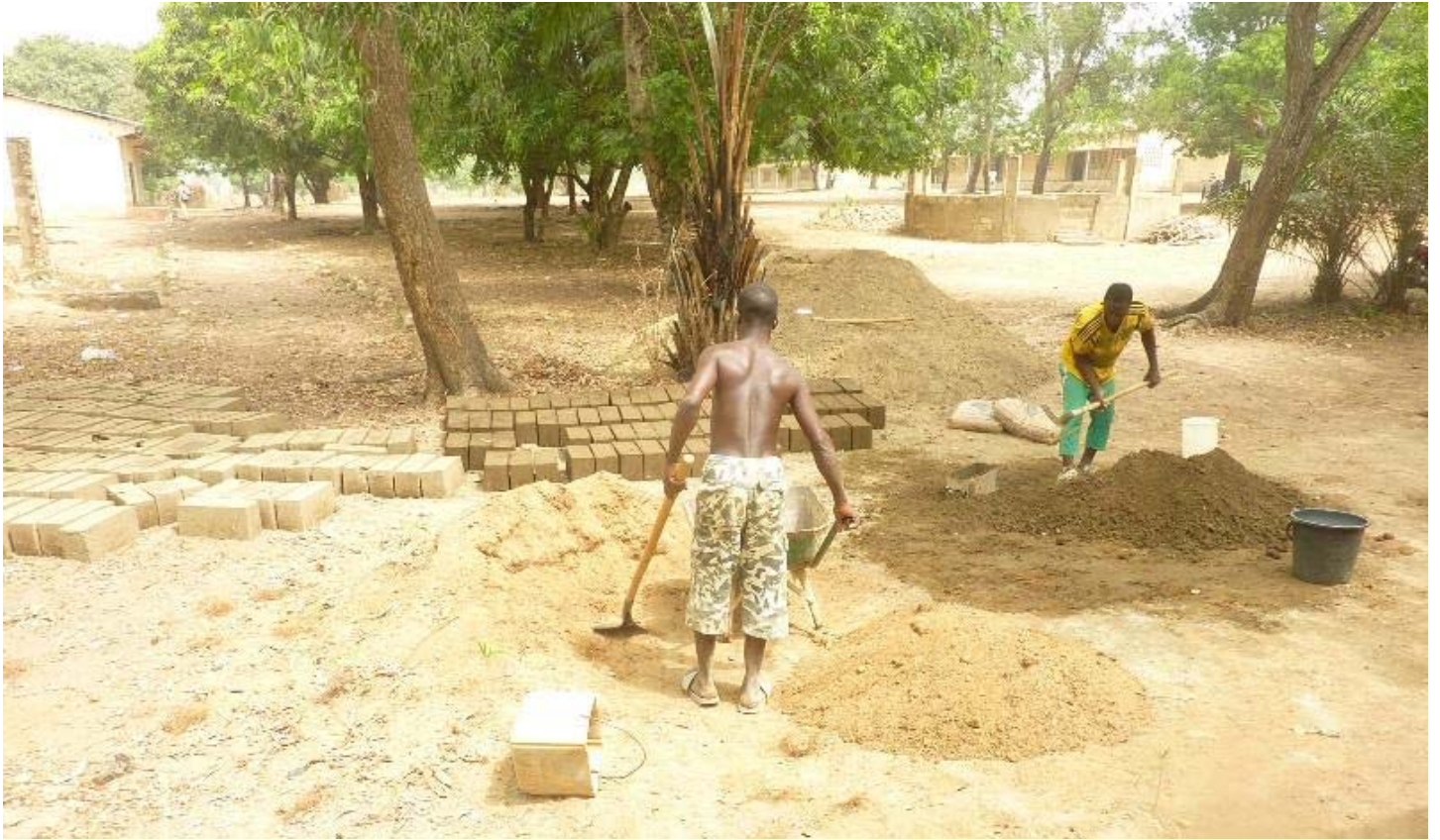
Februar 2016: Vor Baubeginn alle Steine in Handarbeit selbst geformt
