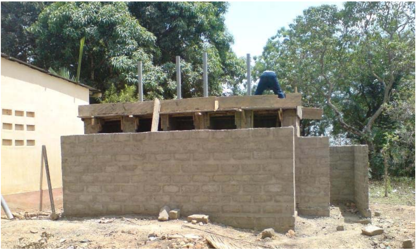
April 2016: Der Rohbau steht.
