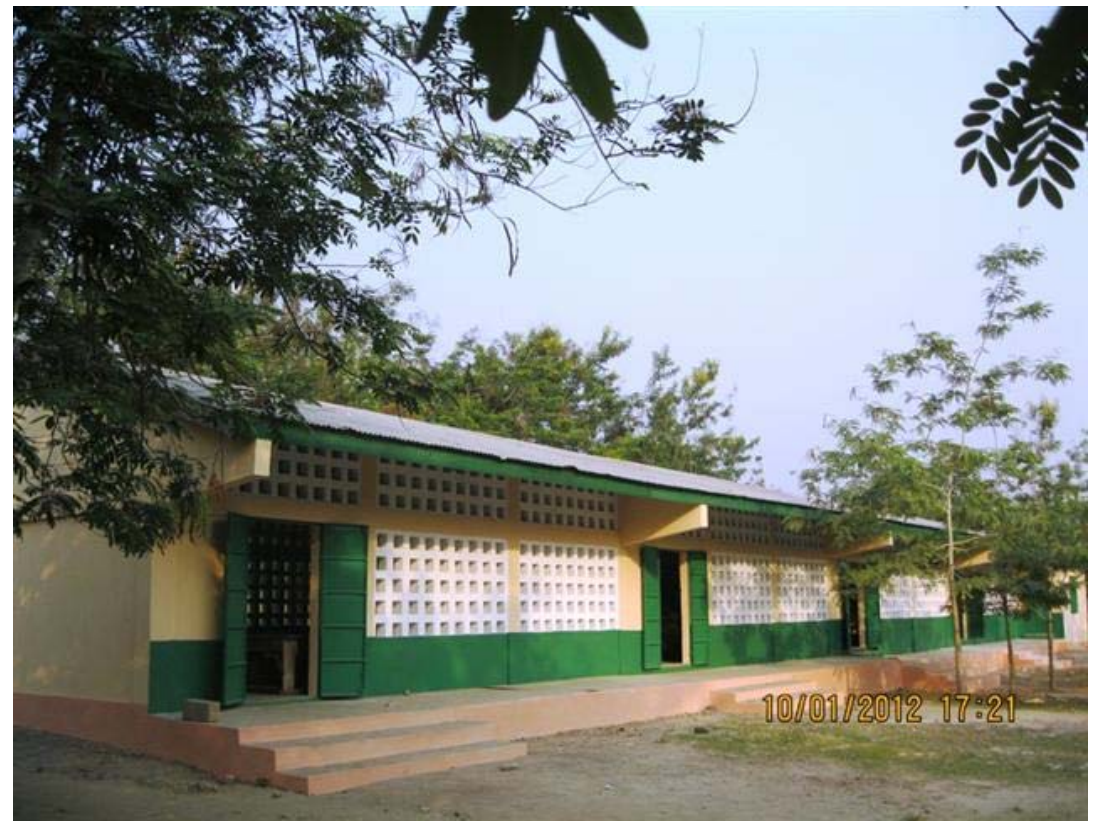
4 Jahre besuchen sie nun die von uns 2012 komplett fertiggebaute Realschule in Kpalimé-Kusuntu.
