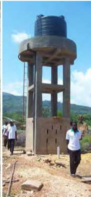
Wir haben auf den Feldern von Novissi und Kusuntu je einen 6 m hohen Wasserturm gebaut
