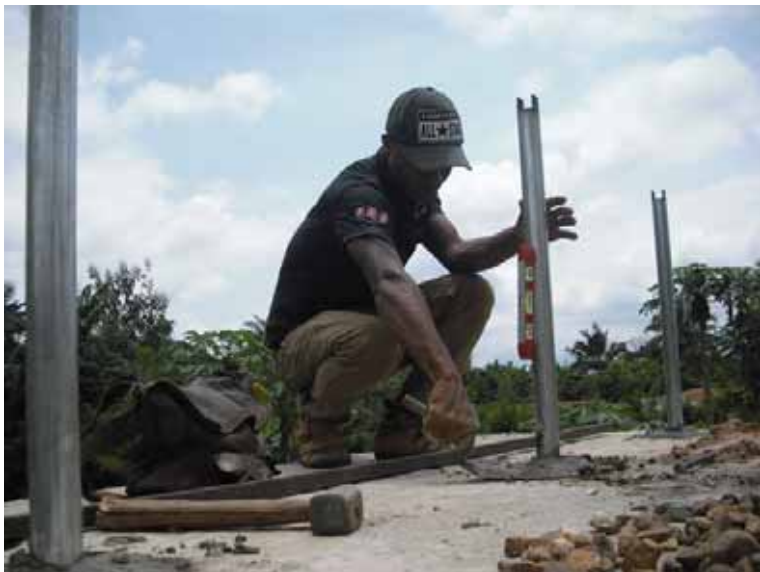
Aufbau des Montagegestells auf dem stabilen Dach der Schutzhütte
