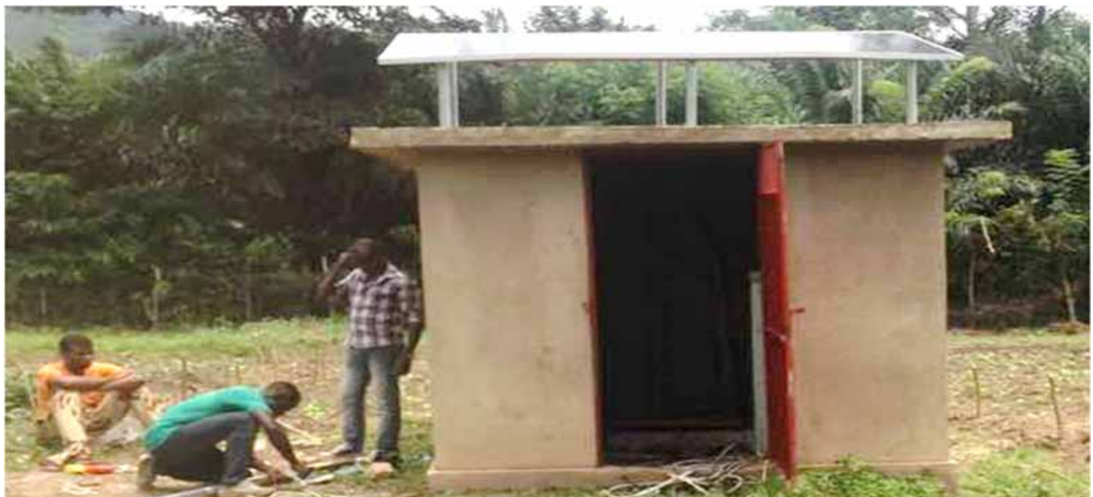
Abschluss 1. Schritt: Die Solarpanels sind montiert
