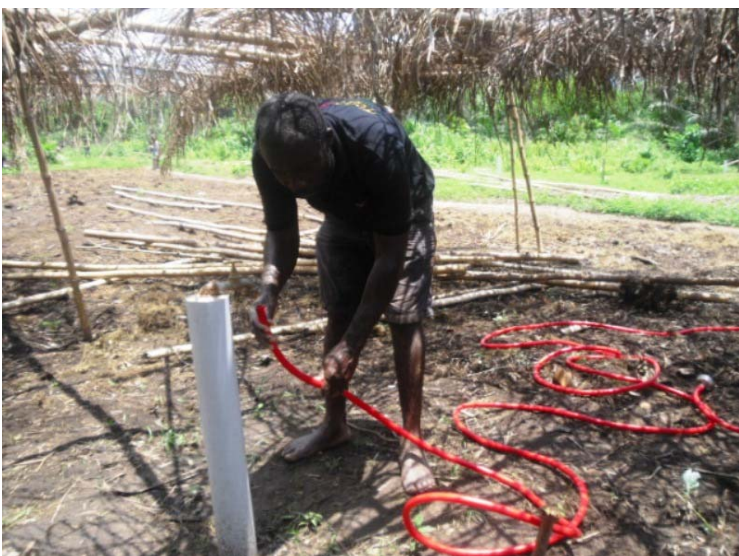
Eine von 12 Zapfstellen für den Anschluss der Bewässerungsschläuche
