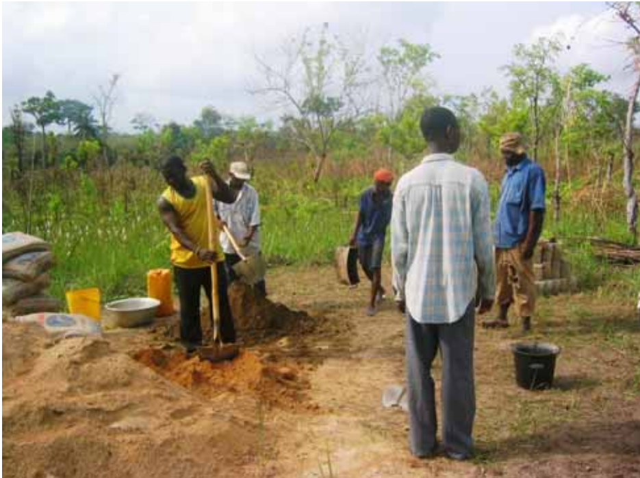
Die Brunnensteinproduktion wird vorbereitet
