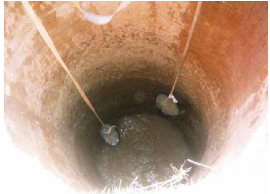
Der Brunnen wird für die Bauarbeiten leer“gepumpt“
