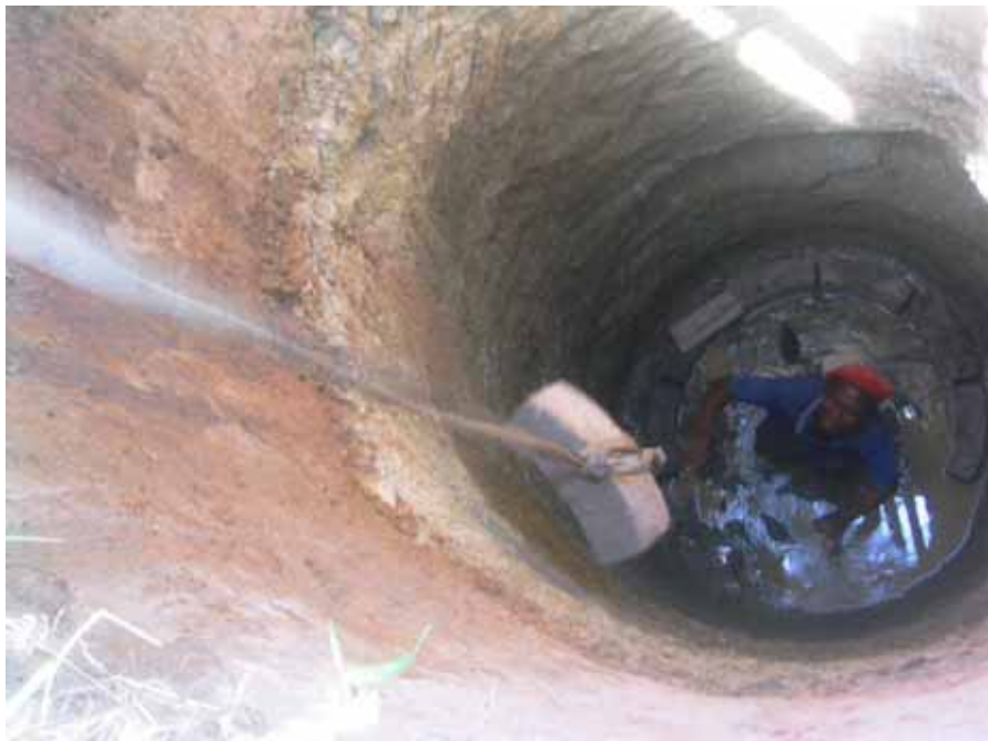
Einzelnen werden nun die vielen Brunnensteine abgeseilt...
