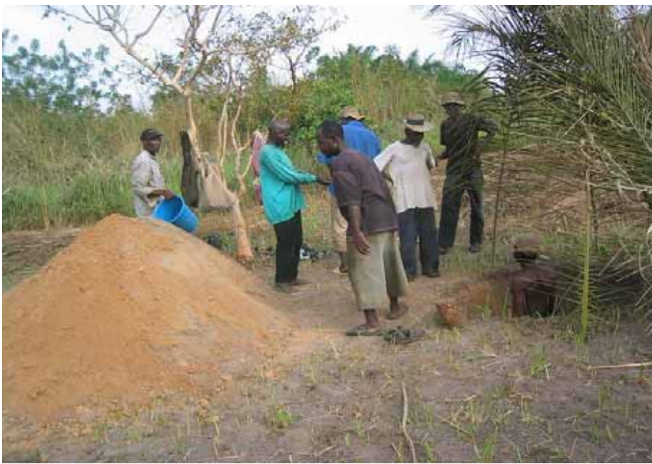
Der Sand aus dem Brunnenschacht wird für die Produktion der Brunnenbausteine verwendet
