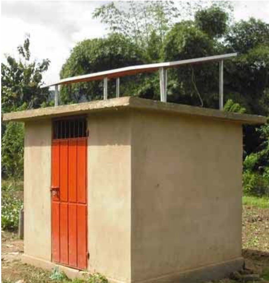
Die Solarpumpen-Schutzhütte mit Trägerdach für die Solaranlage ist fertig gebaut.
